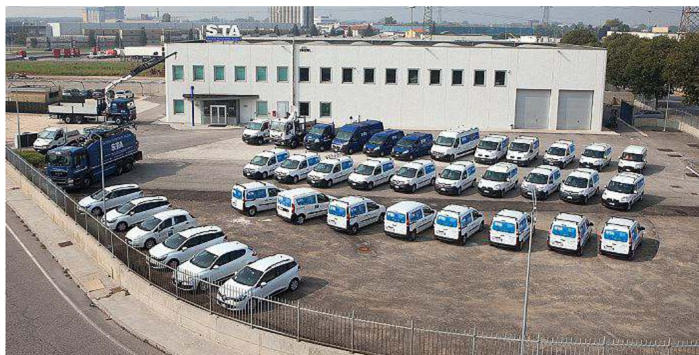
La moderna sede della STA in zona Valdaro a Mantova - www.stacque.com
