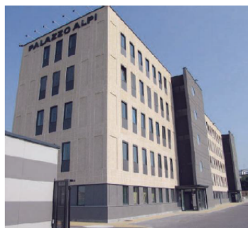
Il palazzo della sede di Apindustria Mantova
