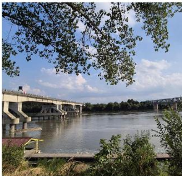
Ponte di Borgoforte L'infrastruttura collega Borgo Virgilio a Motteggiana
