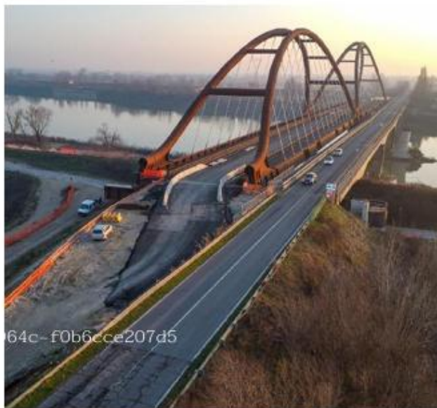
Il ponte di San Benedetto il cantiere partirà a giugno e l'anno prossimo ci sarà la chiusura
