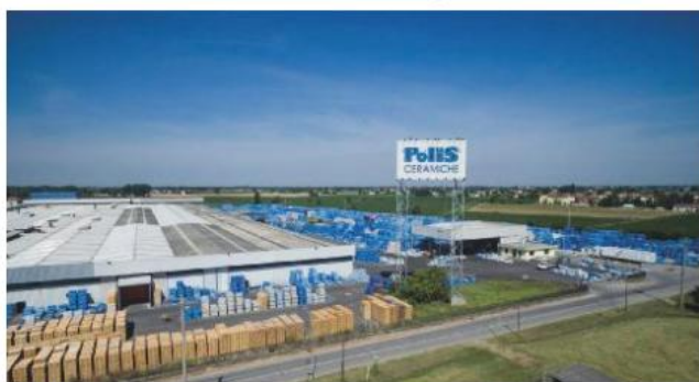
Lo Stabilimento Polis Ceramiche S.p.A. in Via Pavesa 24 46023 - Bondono di Gonzaga (MN)
