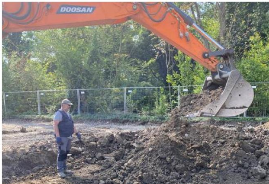
Scavi I tecnici della Covesmi hanno eseguito anche duemila trivellazioni
